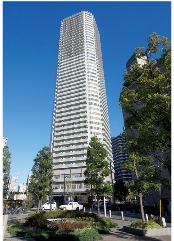
建物外観写真
